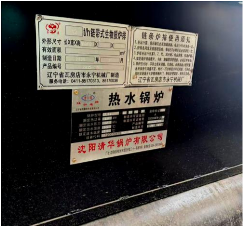
图 1 已新建锅炉铭牌及实物照片
