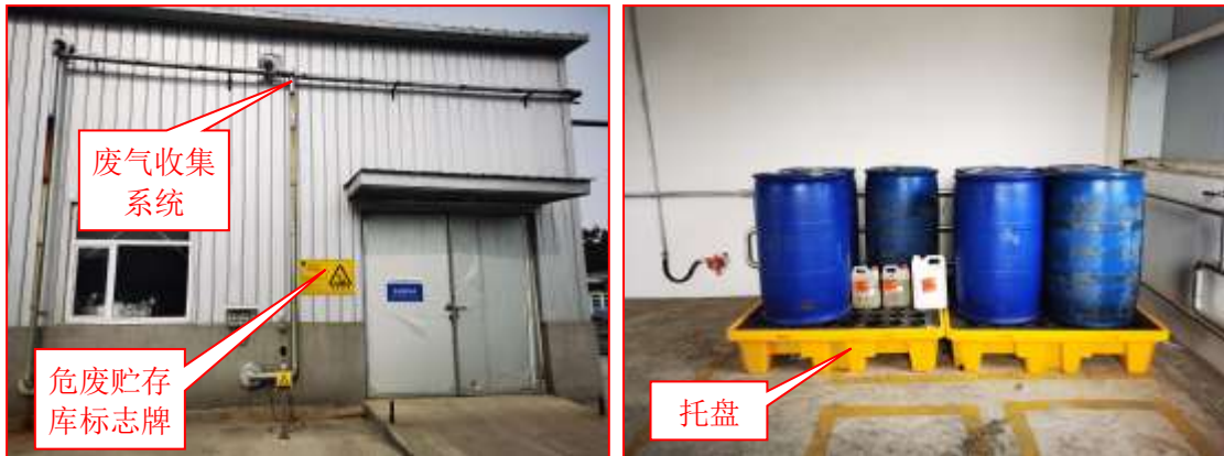
图 2-6 公司危险废物贮存库现在图片
