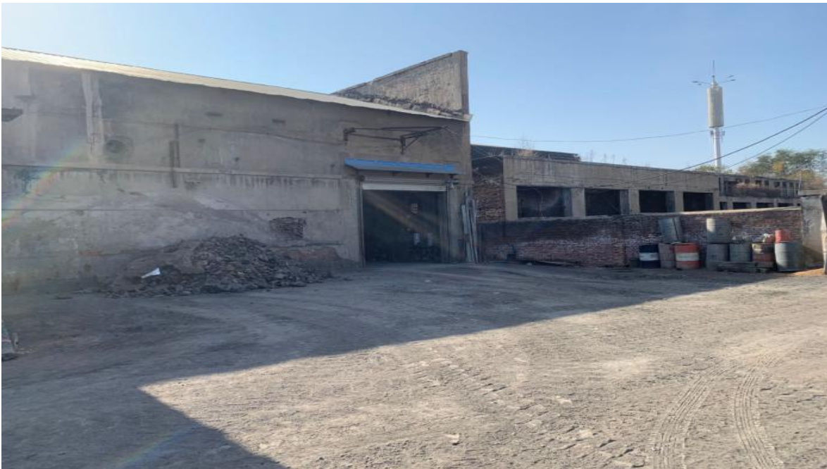
生产车间外部
