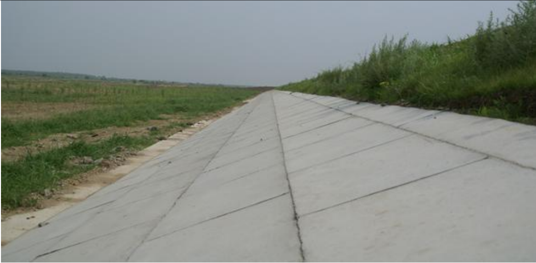
图 2-7 混凝土板护坡
